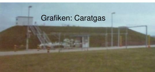
nen, bis zu 70 m lang und haben einen Durchmesser von 6,20 m. Man sieht nur das Pumpenhaus, einen Domdeckel und die zu- und abführenden Leitungen.
